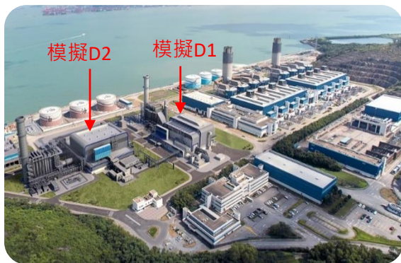
興建D1及D2天然氣發電機組
